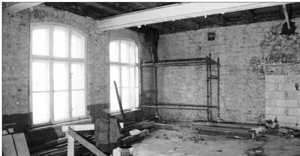
Jedna z remontowanych sal.
