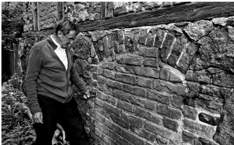
Zamurowane wejście do spichlerza. Fot. W. Leszczyński.
