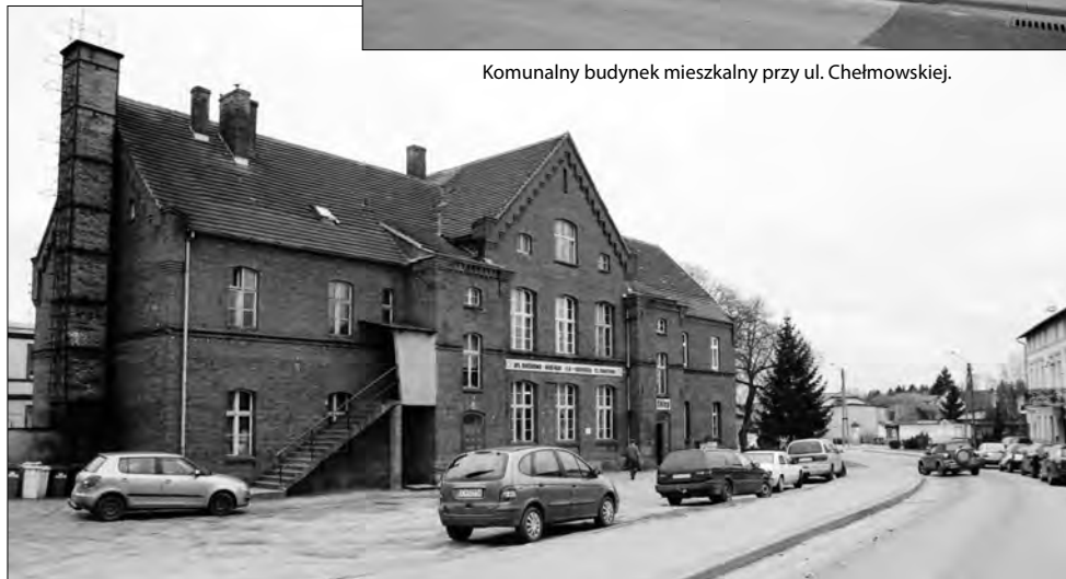
Obiekt przed modernizacją od strony ul. Szkolnej, październik 2020 r.
