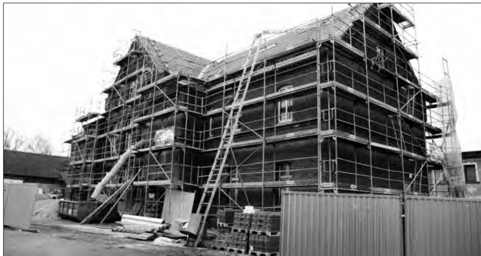
Budynek w trakcie remontu, od strony ul. Szkolnej.
